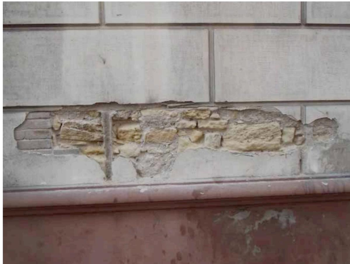
En la imagen se puede apreciar el deterioro causado en la fachada de uno de los edificios de la ciudad fruto de una mala ejecución, una mala selección de los materiales y de la acción del ambiente marino. Al tocar el aglomerante de las piedras, se podía desprender fácilmente.
