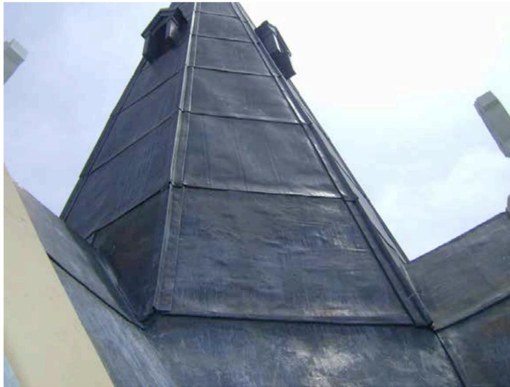
*Proceso de soldadura del planchado de plomo finalizado*
