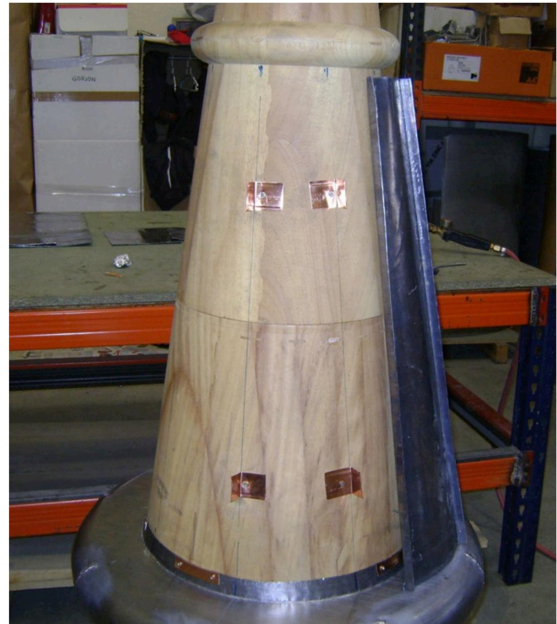
*Proceso de aplacado del pináculo de madera. Se pueden observar las pletinas que se utilizan de centradoras para las placas de plomo y cómo éstas se van moldeando a la forma del modelo de madera.*
