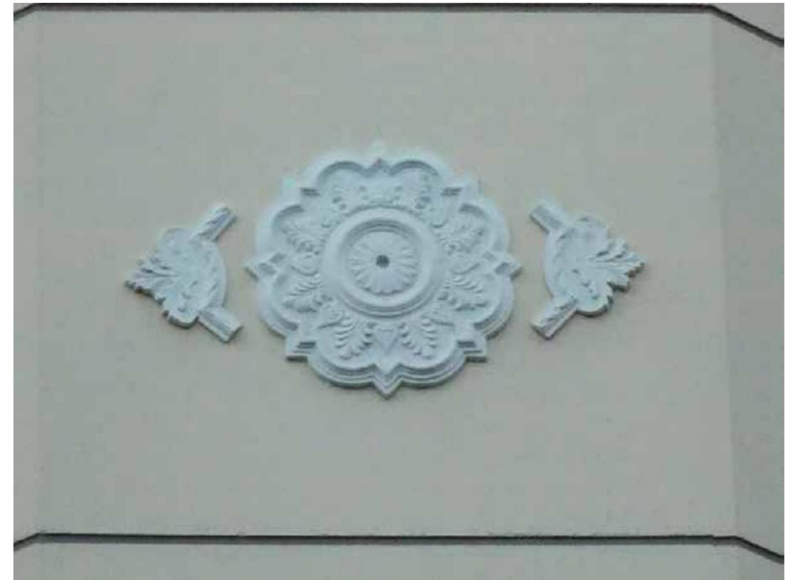
Esta imagen fue añadida en el programa informático y escalada a tamaño real. Seguidamente, con un comando del programa Autocad 2014 llamado "Splines" nos dedicamos a representar el contorno y detalles de toda la pieza.
